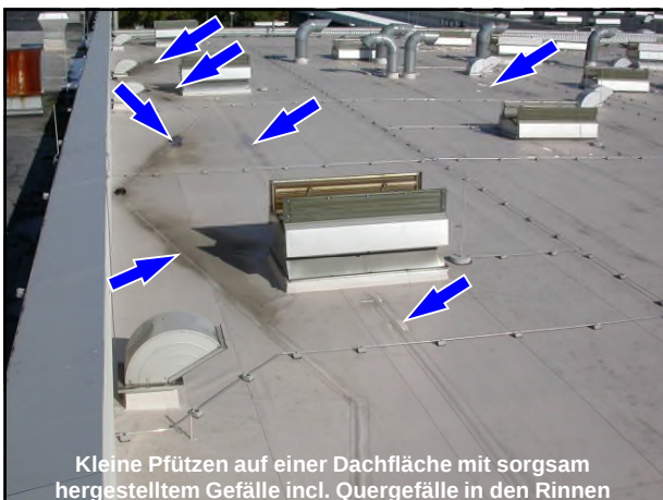
Nicht geplante Anstaubewässerung eines Stahltrapezblechdachs mit Durchhang, das aber seit Jahren dicht ist und keine Probleme bereitet.
