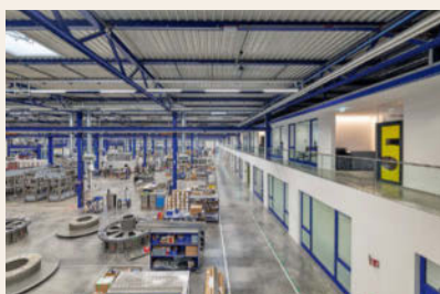
Montagehalle der Firma Woll; Architektur: Brünjes Architekten
